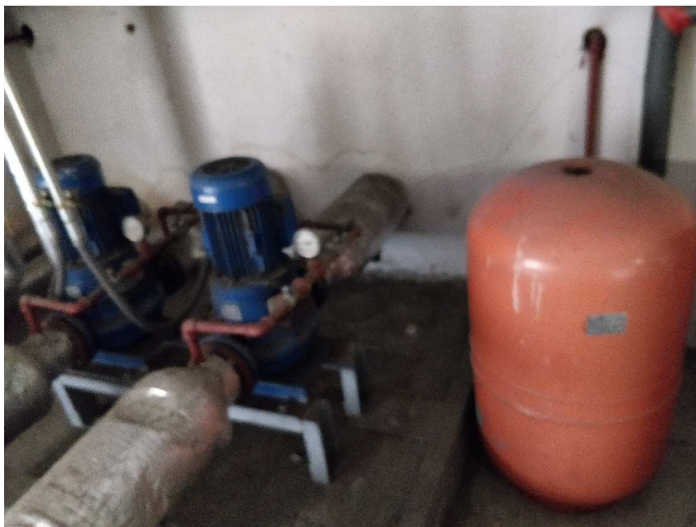
Foto 8 Bombas de recirculación a climatizadores y vaso de expansión
