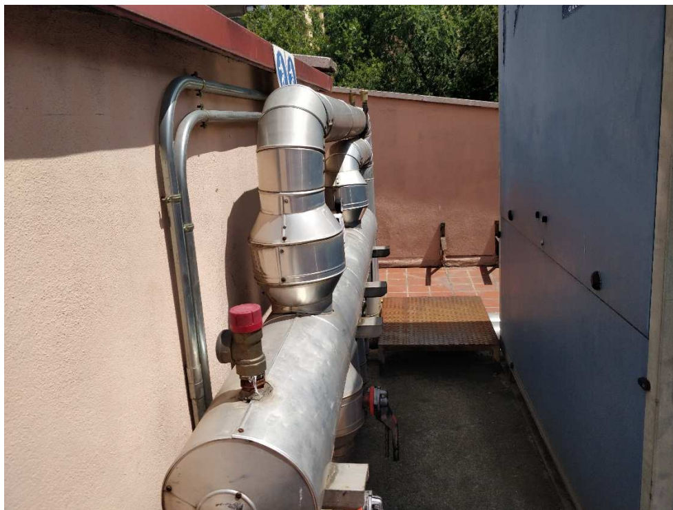
Foto 7 colectores de impulsión y retorno
