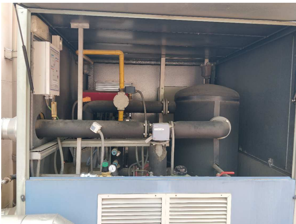
Foto 6 Vista de depósito de inercia y válvula de tres vías motorizada
